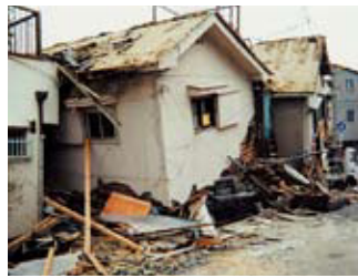
阪神・淡路大震災で倒壊した家屋 (東京消防庁 提供)
