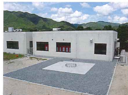
山口管制局（次世代システム用管制棟）
