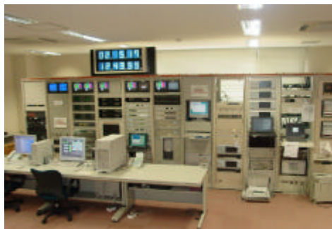
山口管制局映像送受信設備
