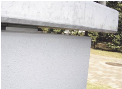
免震局舎の土台
