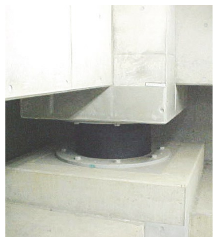
(下) 衛星通信局舎地下免震装置
