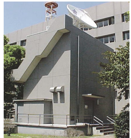
(上) 福岡県衛星通信局舎
