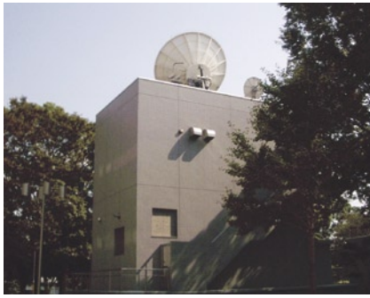
衛星通信局舎（免震局舎）
