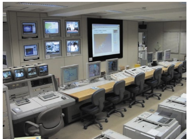
写真 通信管理室
