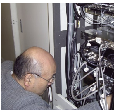
映像デジタル化機器 設置状況の確認
