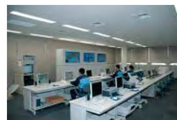
統制室（和歌山県防災センター3F）
