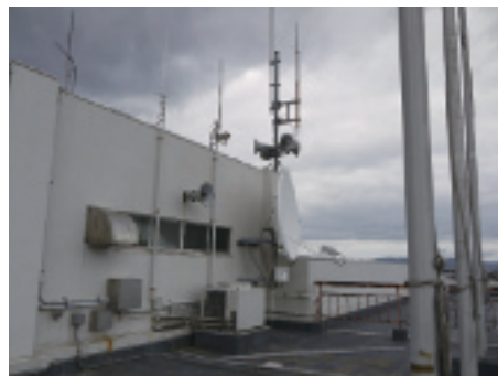
東松島市庁舎のVSAT設備
