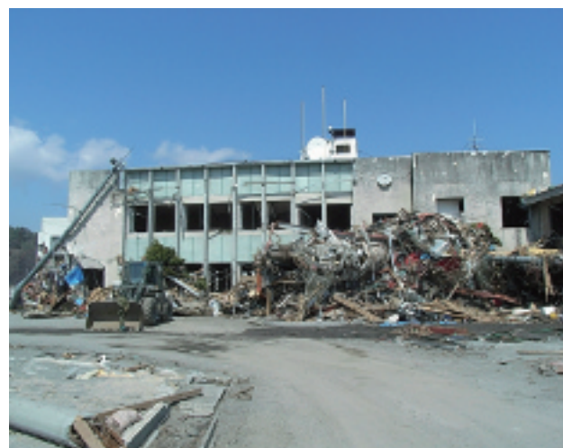
写真3 岩手県大槌町役場の被災状況
