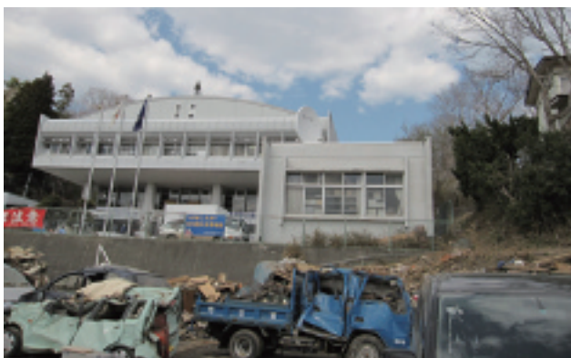
宮古市田老総合事務所
