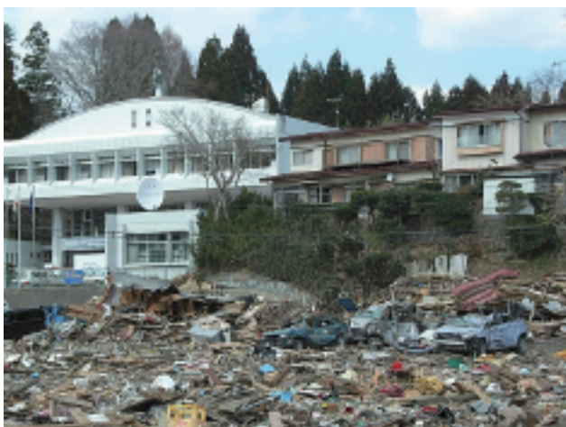
写真2 岩手県宮古市田老総合事務所周辺の被災状況
