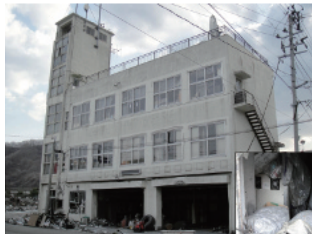
津波で浸水した釜石大槌地区行政組合消防本部
