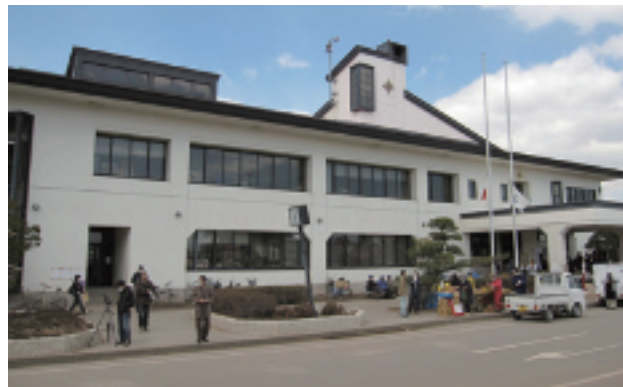
1階が浸水した野田村役場
