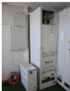
常陸太田市VSAT設備：ラック下段のコンセントから隣接するPBXに給電して停電対応した。
