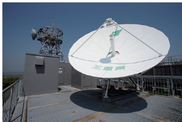
図. 三重県庁局4.5m φアンテナ
