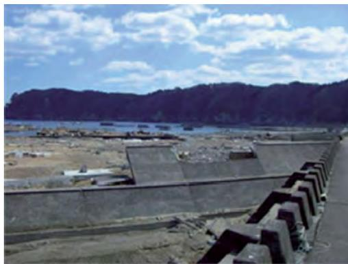
写真 6.4 破壊された防波堤、防潮堤
