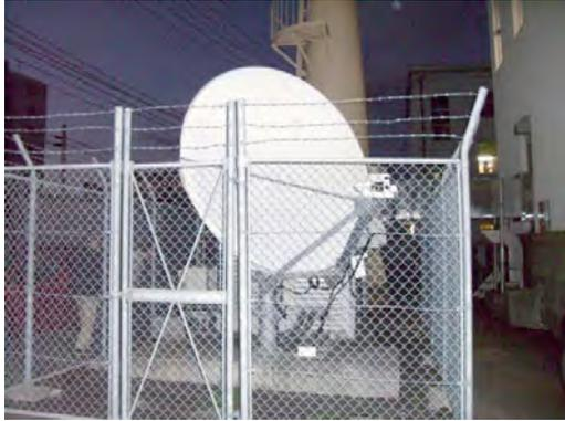
写真 6.35 地上に設置された VSAT アンテナ
