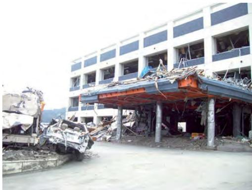
写真 6.12 陸前高田市役所 庁舎は津波で被災し使用不能
