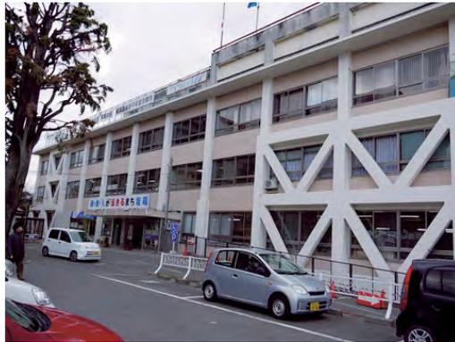
写真 6.25 塩釜市役所 庁舎は耐震補強がされている
