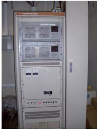
写真 6.39 7F 通信機器室に設置されている VSAT (第 1 世代) IDU
