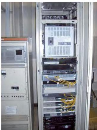
写真 6.40 4F 機器室にある VSAT 第 1 世代 IDU (左) と構築中の第 2 世代 IDU (右)
