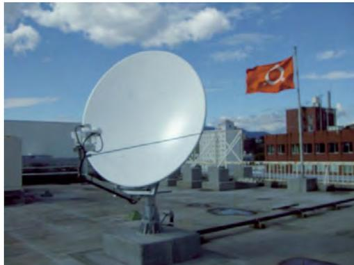
写真 6.42 屋上に設置された VSAT アンテナ
