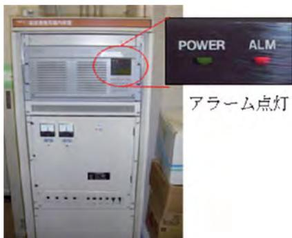
写真 6.32 故障したままの第一世代 IDU
