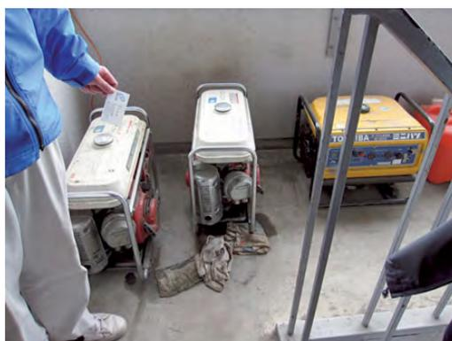
写真 6.6 宮古市役所 発動発電機運転により地域衛星通信設備を維持した
