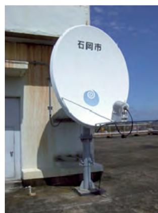
写真 6.56 屋上の VSAT アンテナ
