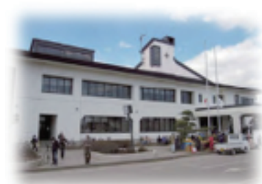
東日本大震災の津波による浸水の中でも通信を確保[岩手県野田村役場]
