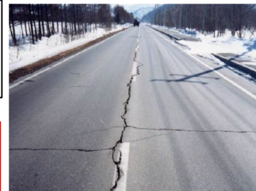
凍上災害による 舗装の損傷事例
