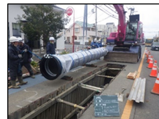
（耐震管の敷設工事）
