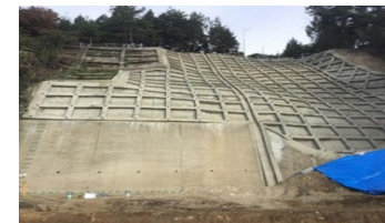
斜面の崩壊防止対策 (法面防護工)
