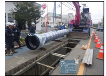
（耐震管の敷設工事）
