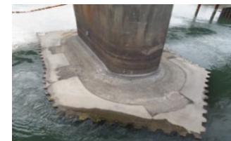
橋りょうの流失・傾斜対策 (シートパイル工)
