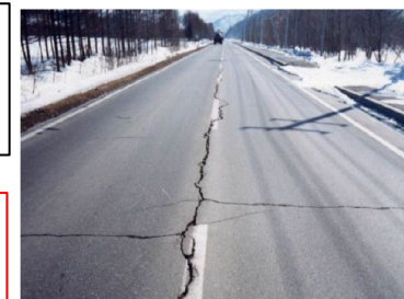
凍上災害による 舗装の損傷事例
