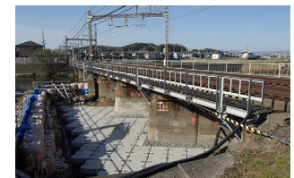
橋りょうの流失・傾斜対策 (根固め工)
