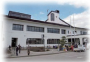
東日本大震災の津波による浸水の中でも通信を確保[岩手県野田村役場]
